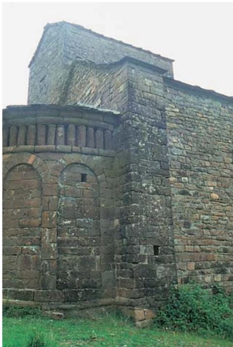
*Detalle del contrafuerte que asegura la unión del ábside y de la nave en San Andrés de Satué*
