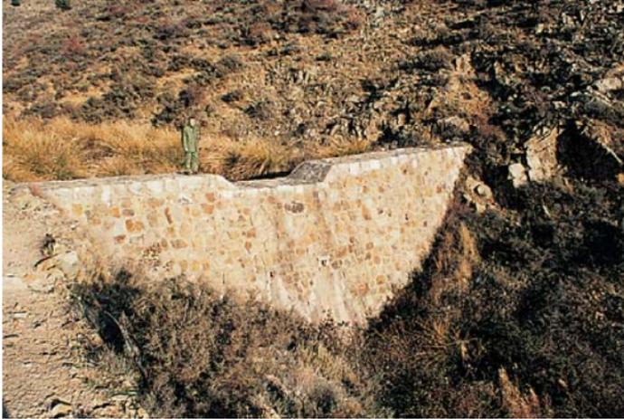
*Obra transversal para corregir la erosión en el barranco "Las Minas" de Torrijo de la Cañada (obra realizada en 1963). Obsérvese la acumulación de sedimentos, estabilizados por vegetación natural (Foto: I. Pérez-Soba)*
