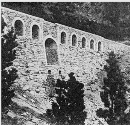
*Dique vacío con alcantarillas superiores,
